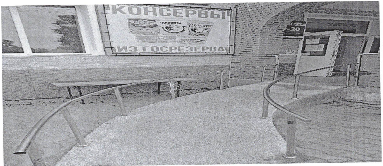
Фото № 2: нарушения устранены
